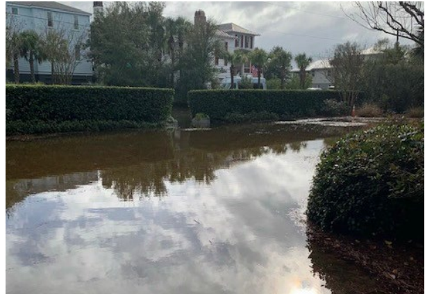
Bayonne St (near STA 26 ½)
