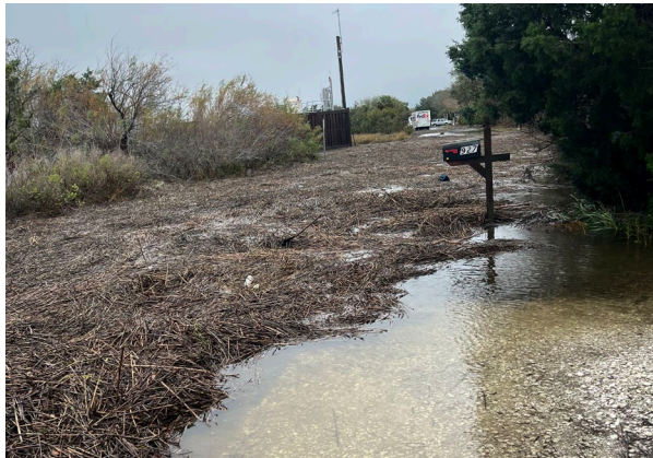
Osceola Avenue (near STA 9 ½)
